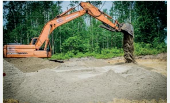
Le sable filtrant est un composant important d'une installation System O))
