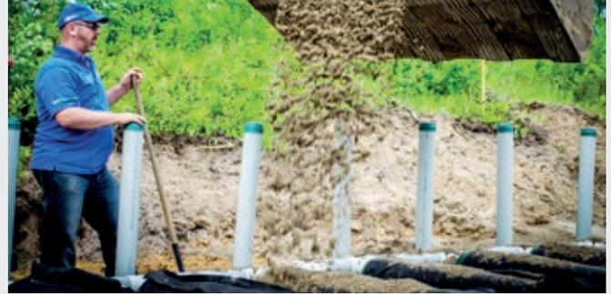
Les piézomètres permettent de mesurer l'hauteur de l'eau à l'intérieur de chaque conduite et s'assurer de la distribution uniforme de l'eau usée.
